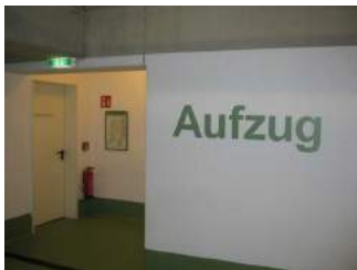
Verbindungstür von der Tiefgarage zum Aufzug am Foyer.
