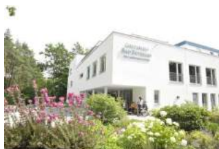
Außenansicht vom Gästehaus Bad Bevensen.
